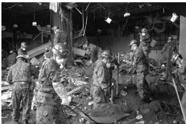
自衛隊による回収作業協力（4 月 26 日）
