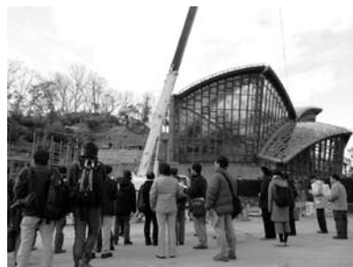
図6 RWS1 新館建築現場の見学
