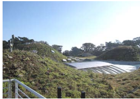
屋上 Living Roof の風景
