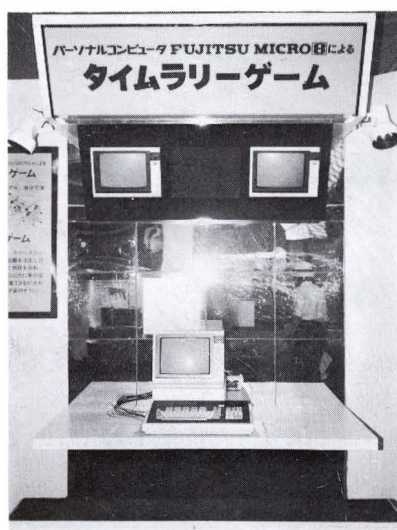
「情報未来館」富士通展示(コンピュータゲーム)
