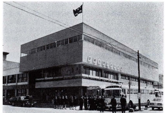
館正面(西北側よりのぞむ)
