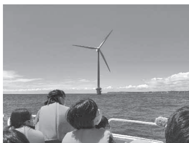
船上より洋上風力発電視察 「東電 RP 銚子沖設備」
