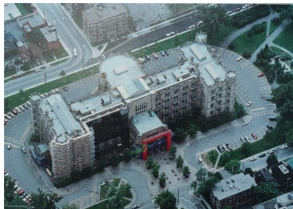
写真1：博物館の全景（修復中）正面のガラスのホールはまだない。
