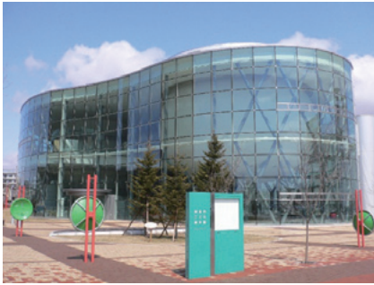
図① 全面ガラス張りの外観
