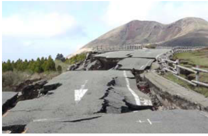
写真1 草千里展望台付近の道路崩壊の状況(2016年4月17日)
