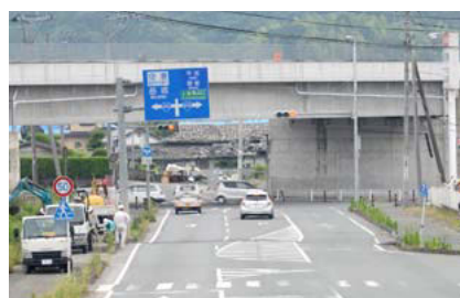
写真5 御船町北部の地震断層(右横ずれを示す)
